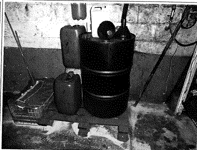
Stockage de liquide hors rétention.
